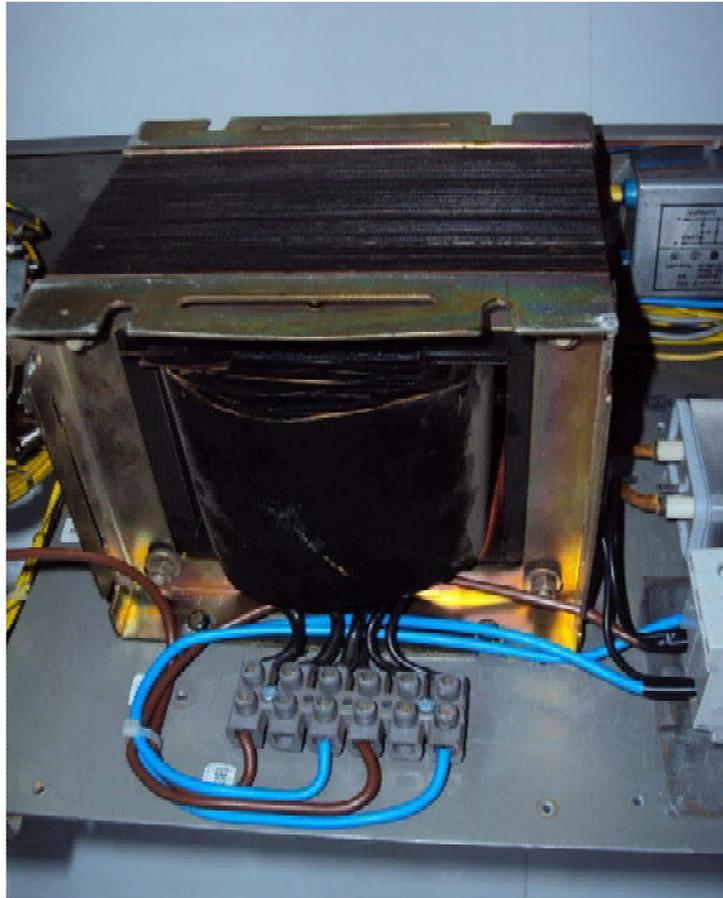
**Particolare trasformatore di isolamento visto dal lato collegamenti**
